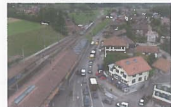
Überlastete Ortsdurchfahrt in Hasle b.B.
