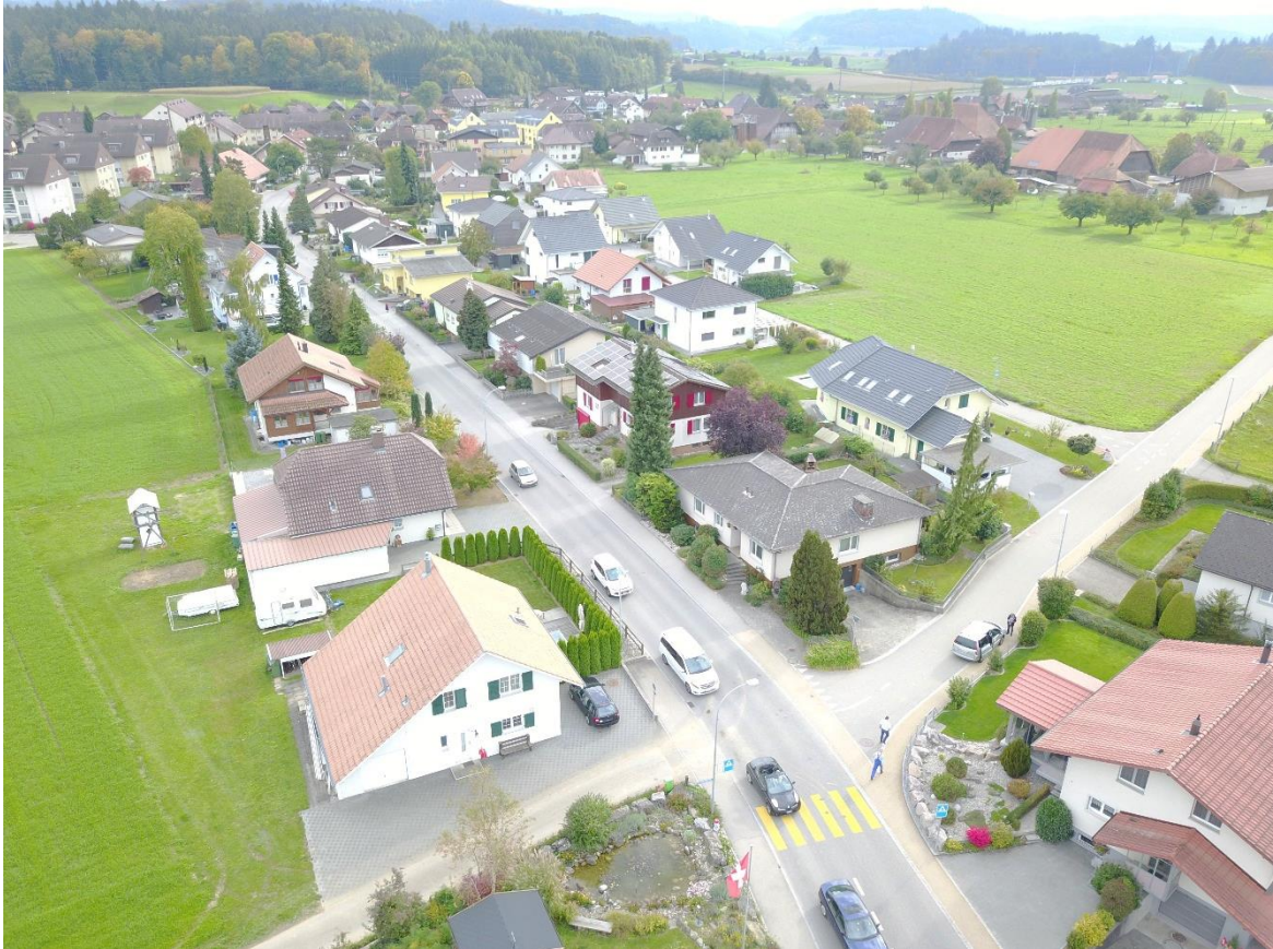
Bild 2 - Situation Richtung Dorfstrasse - IGVL 28.09.2017
